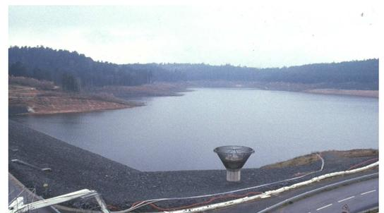
Haut de 78 mètres, le barrage est en partie composé de trapp, la roche la plus dure d'Europe, qui ne gèle pas et n'est pas perméable. Le cœur du barrage est quant à lui composé d'argile et de grès. La largeur est de 355 mètres à la base et de 8 mètres à la crête, longue de 330 mètres. Le volume d'eau maximal est estimé à 61.6 millions de m<sup>3</sup>.
